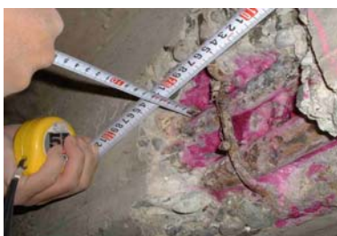
●配筋調査・中性化試験
