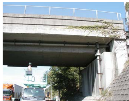
●高所作業車による調査
