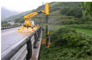
●橋梁点検車による調査
