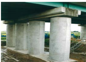
●コンクリート巻き立て
