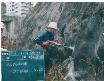
● コア抜き調査
